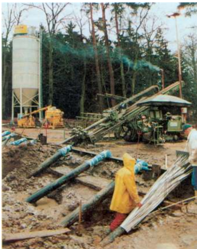
■ Abb. 3: Jet-Drill-Anlage der Firma BOHLEN & DOYEN beim Bohren, vorn fertiggestellte Bohrungen mit eingezogenen 225 mm Verpreßelementen.
