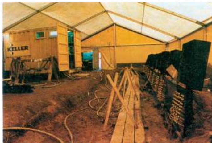
Abb. 8: Verpreßelementköpfe und Verpreßcontainer westlich d. Schleuse.
