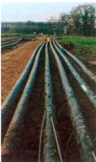
Abb. 7: Vorbereitung der Verpreßelemente auf der Pipe-Seite.
