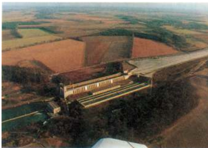
■ Abb. 2: Schleuse Uelzen, im Vordergrund die Sparbecken, hinten links die Trasse zur Vorbereitung der verpreßelemente.
