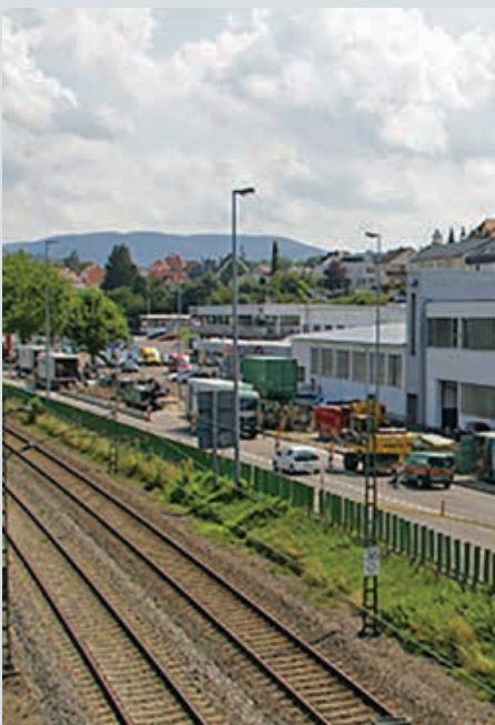
Große Baustelle auf der Konrad-Adenauer-Straße beim Bahnhof Reutlingen West
