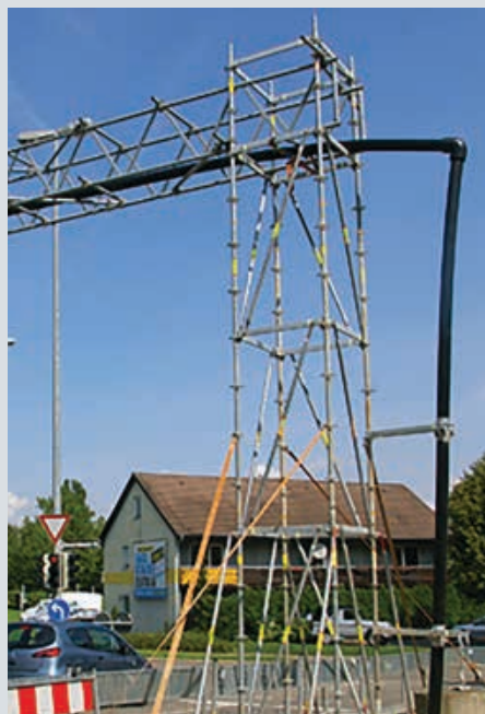
Spülleitungsbrücke über die Schafstallstraße
