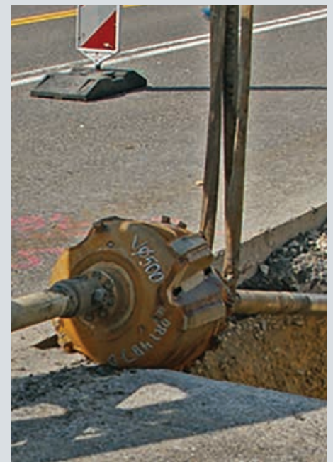
Bohrkopf Ø 500 | Alle Fotos: Max Wild GmbH
