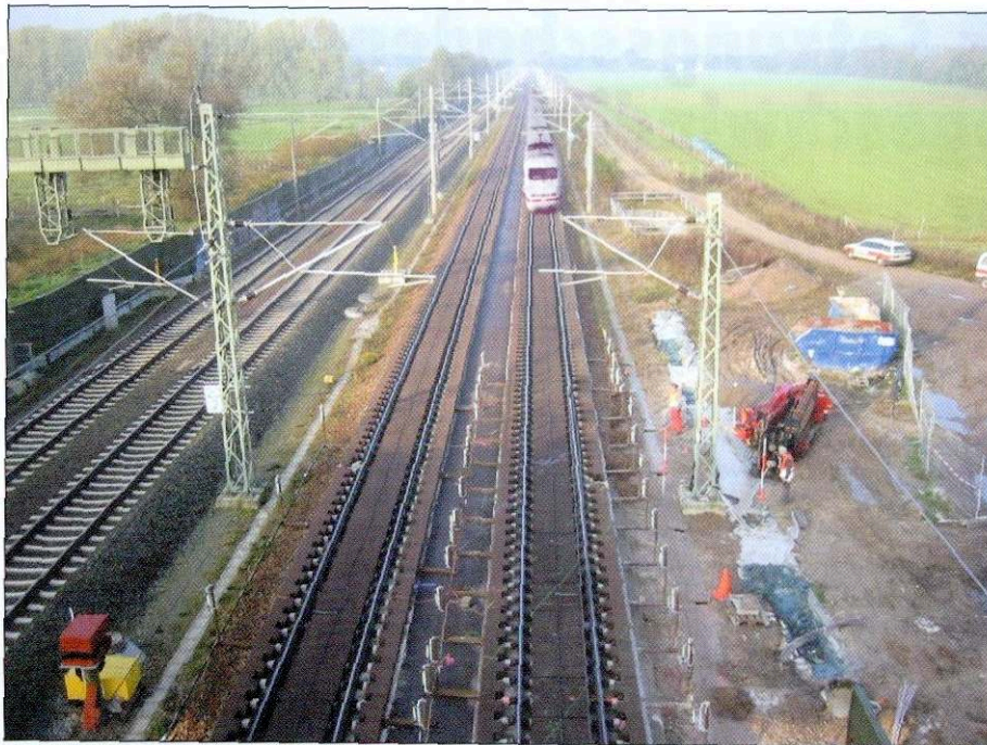
Abb. 3: Links Standort des Digitalnivelliers, rechts Ansatzpunkte der GFI-Bohrungen
