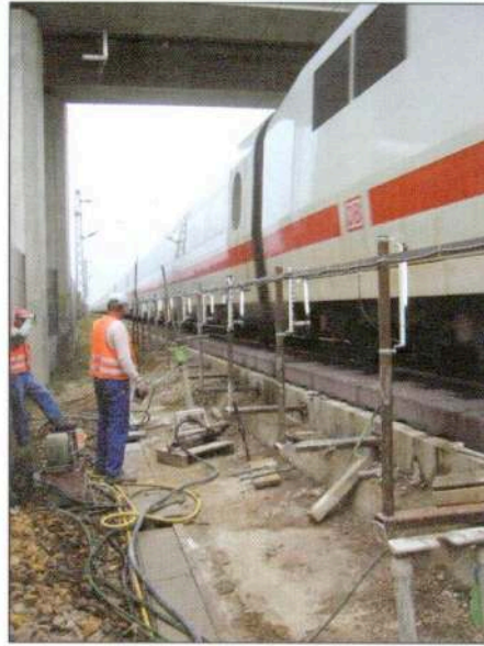
Abb. 6: Rammlanzeninjektion Fa. Spesa
