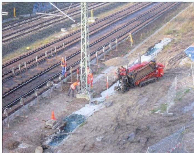
Abb. 10: Herstellung der GFI-Bohrungen
