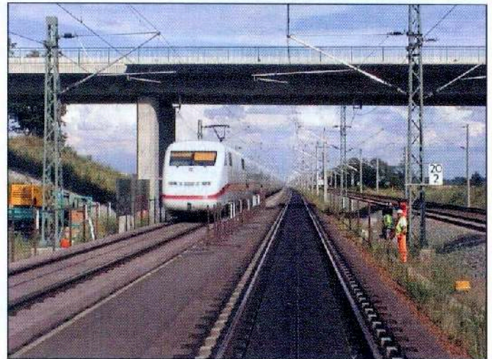
Abb. 1: Feste Fahrbahn mit Konsolen für das Digital-nivellier-System
