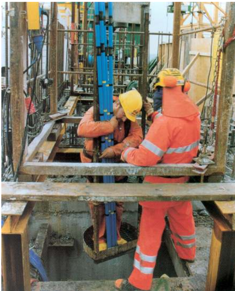
Mitarbeiter der Keller Grundbau GmbH beim Einfahren in den Caisson
