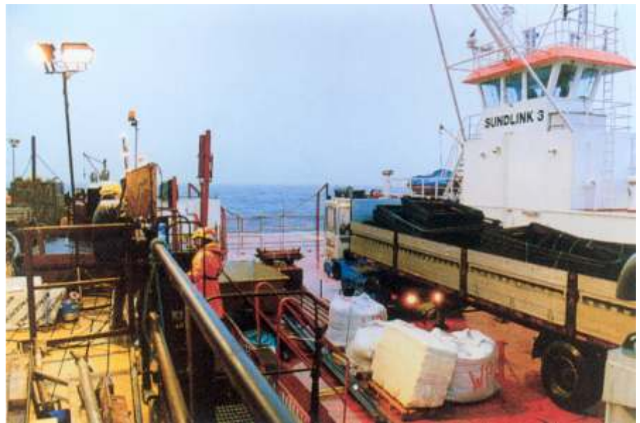
Anlieferung des Injektionsgutes in seewasserdichten Big Bags mit einer Arbeitsfähre des Auftraggebers Sundlink
