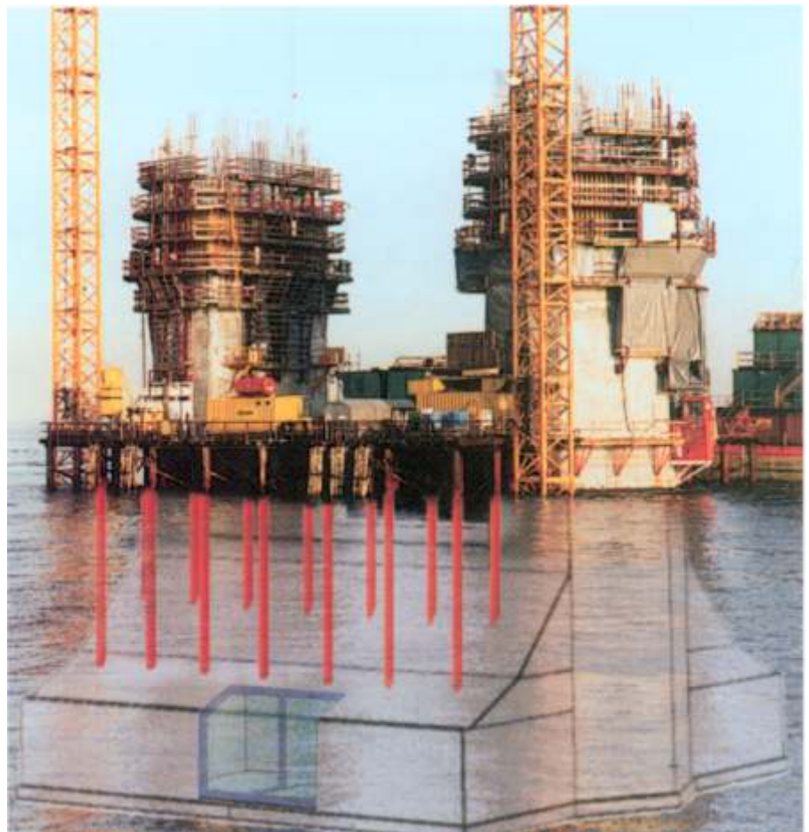
Westpylon mit schematischer Zeichnung des Unterwasserteils
